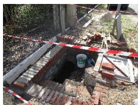
Aménagement de la fontaine Saint Bernard rue de Vierzon
